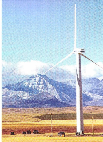
Source : Vision Quest Windelectric Inc. Une éolienne d'une capacité de 600 kw à Belly River (Alberta).
