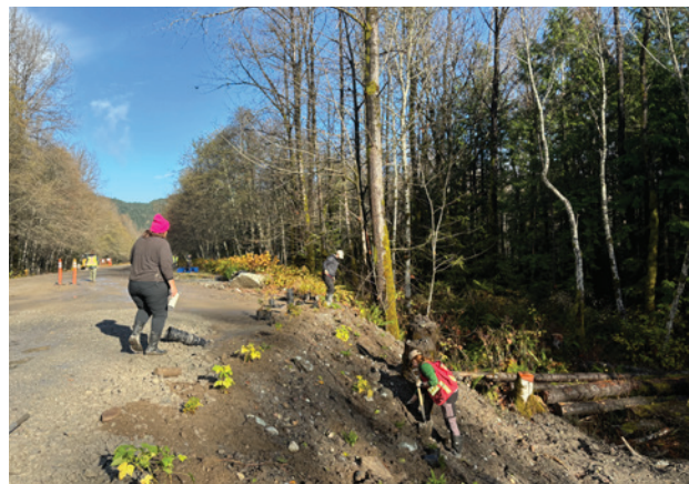
Le Centre d'expertise en restauration de l'habitat a aidé la Squamish Watershed Society à procéder à de nouvelles plantations après l'installation du ponceau. (Photo par Sydney Bryce, MPO)
