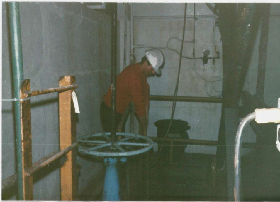
Vue de l'emplacement du point 1
