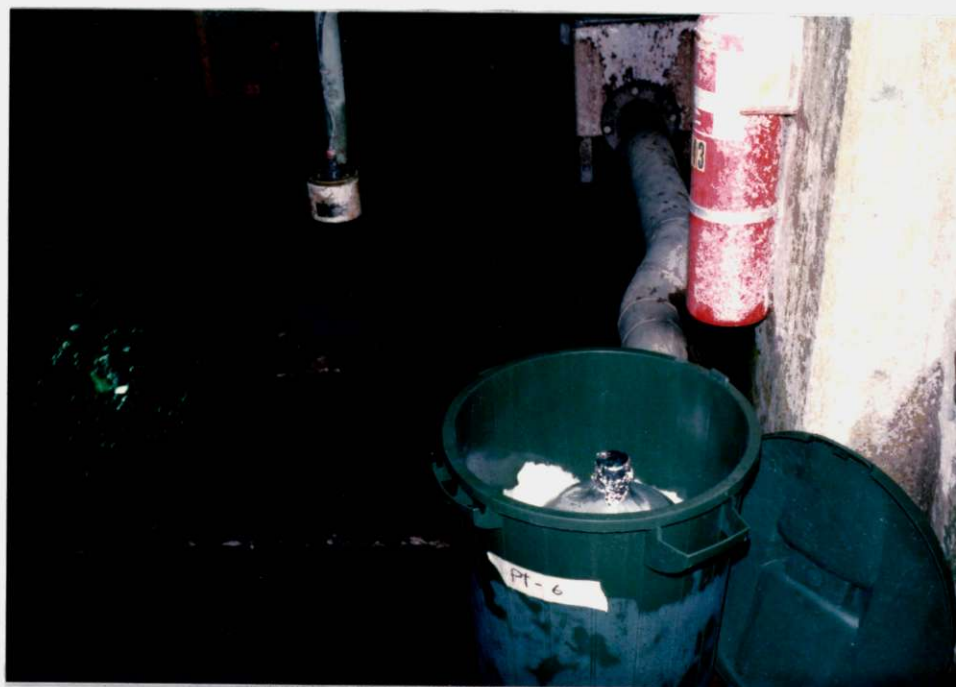
Vue de l'emplacement du point 6
