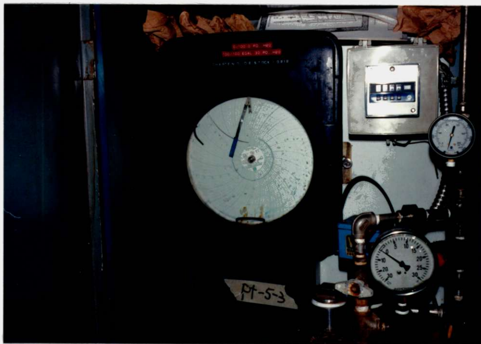
Vue de l'appareil de mesures du débit du point 5-3
