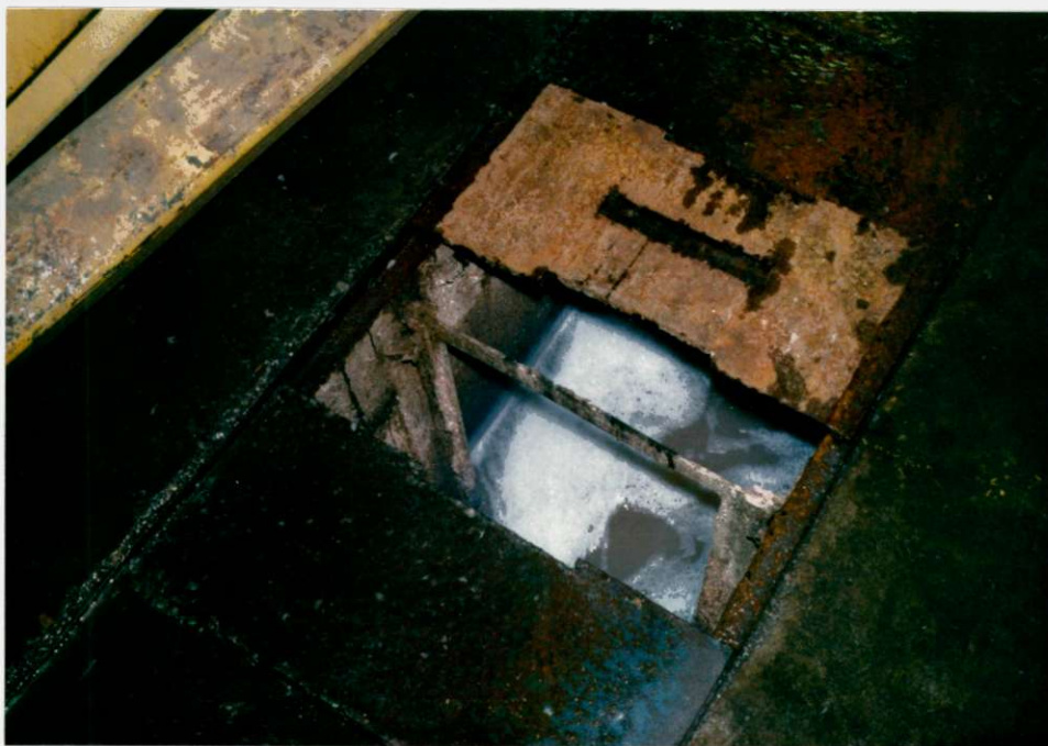
Déversoir rectangulaire de 451 mm d'ouverture.
