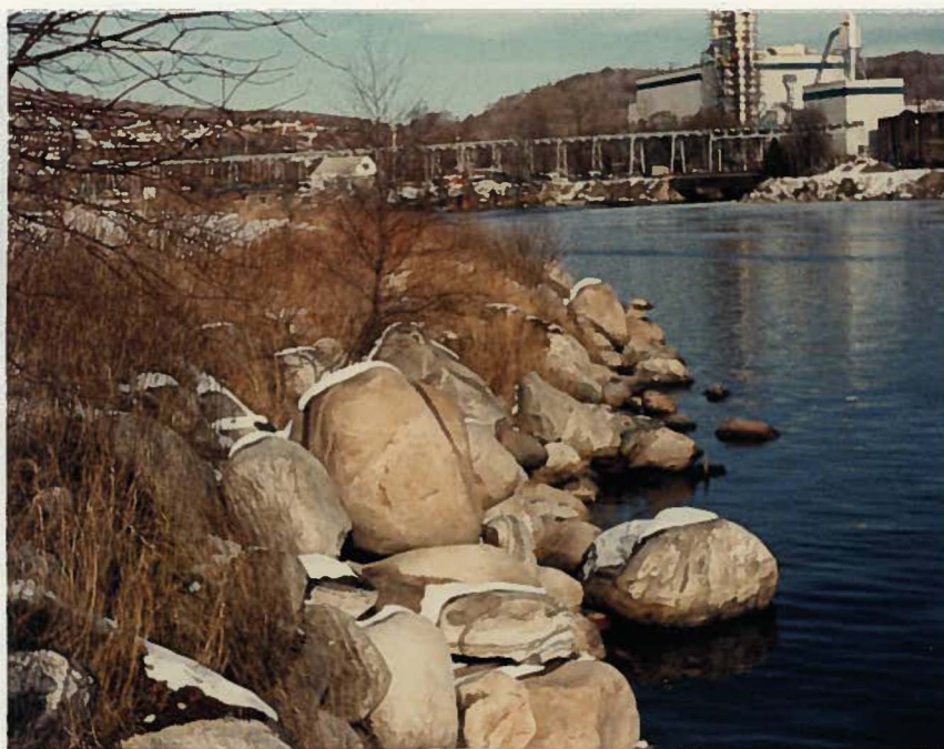
Vue rapprochée de la rive sur l'île dans l'axe du F-7 province de Québec. On note la présence de cailloux et blocs agissant comme protection de la rive.
