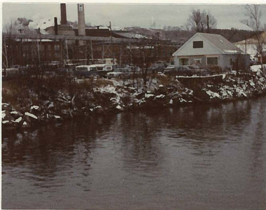
Vue d'un mur de soutènement à protéger, rive gauche, province de Québec. Le BM No. R.N. MD x C se trouve sur le mur de béton.
