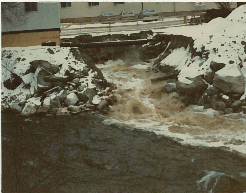
Vue du déversement des eaux usées en provenance de l'usine Tembec, dans l'axe du forage F-9.
