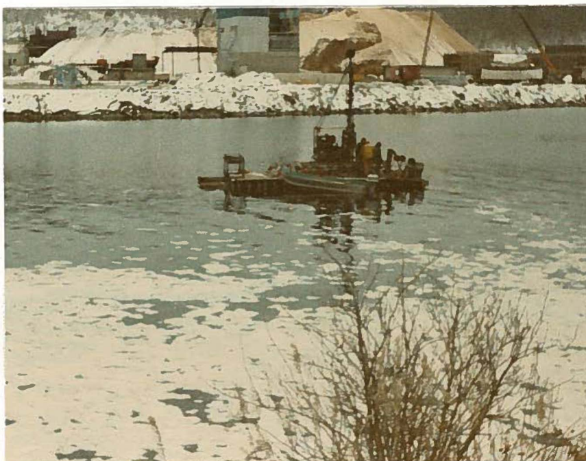
Foreuse montée sur barge
