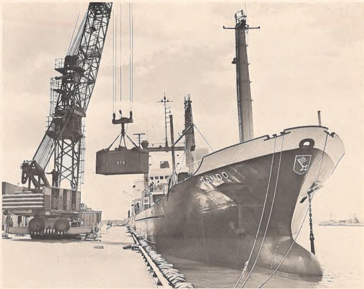
Une grue roulante Gottwald décharge un conteneur du Rando nolisé par la Head Line. C'était le premier vaisseau entièrement cellulaire à jeter l'ancre à Toronto.
