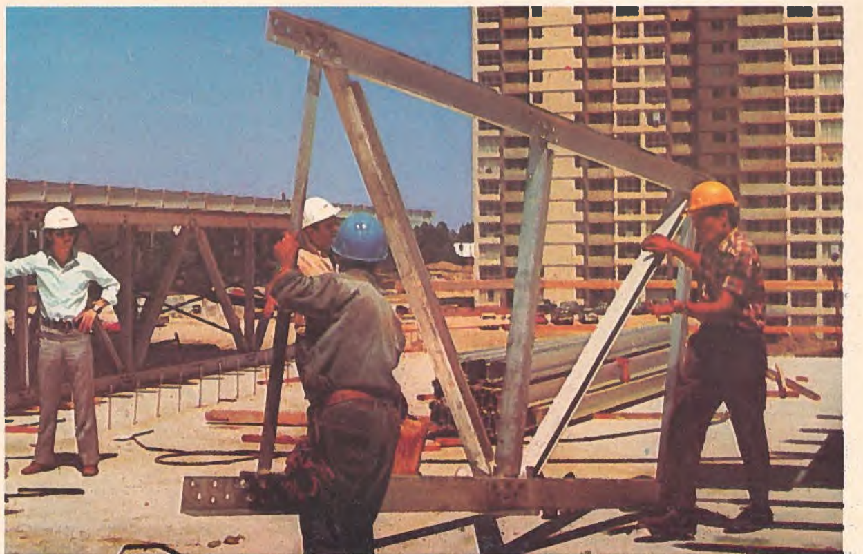
Montage de panneaux de coffrage à béton par les employés de la société Aluma Buildings Systems Inc.
