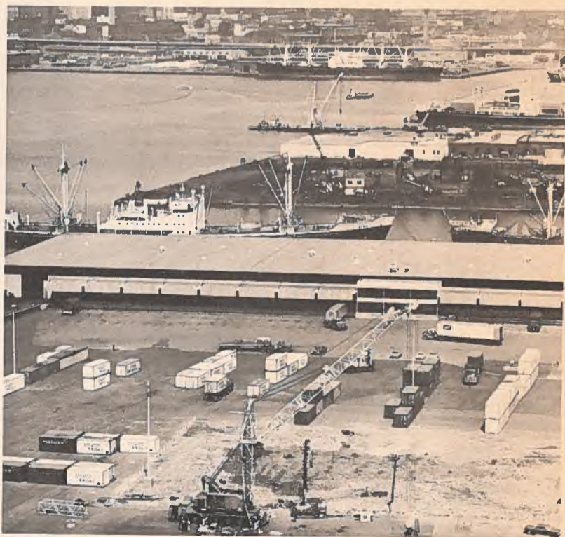
Vue de la partie est du port de Toronto. Au premier plan, la grue Gottwald est soumise à des essais.
