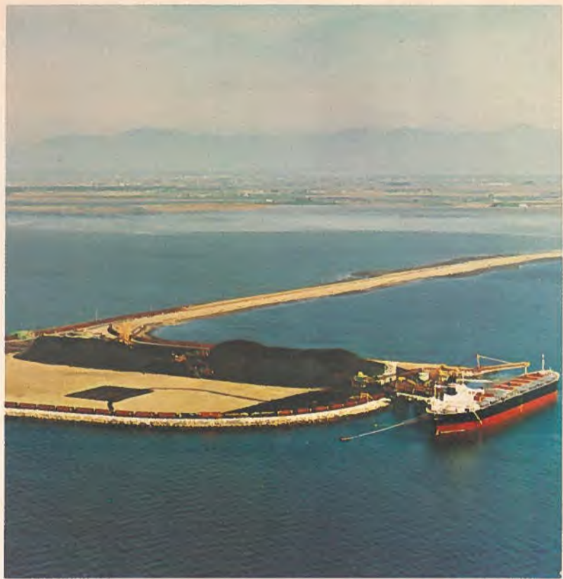
Le "Superport" Roberts Bank, au large de la côte ouest du Canada. Cet énorme port exécute le déchargement des wagons de chemin de fer, le stockage, la récupération ainsi que le chargement des navires. Swan Wooster Engineering était chargé du projet qui comprenait l'étude des divers moyens de manutentionner les matériaux et la préparation des devis estimatifs.
