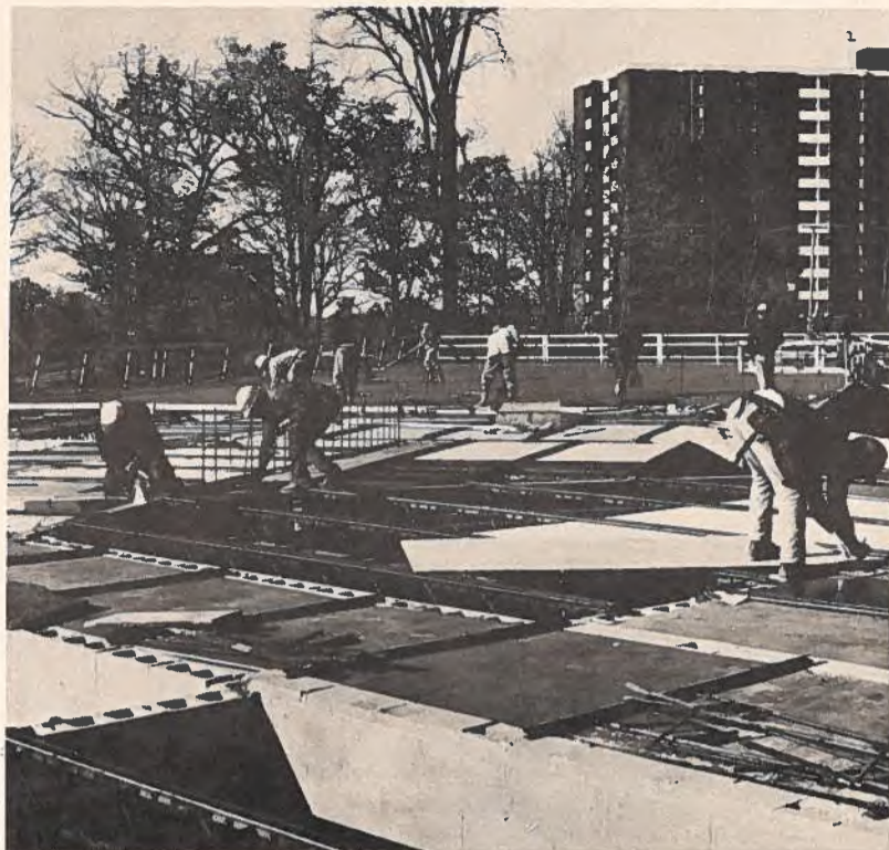
Ouvriers mettant en place le système de dalle composite Hambro D-500 pour la construction d'immeubles d'habitation.
