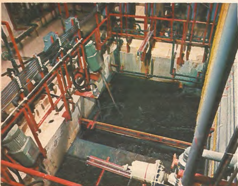
Après avoir été désintoxiqués, les effluents sont regroupés dans ce réservoir installé au secteur d'entretien des moteurs à la base d'Air Canada, à Dorval. Ce système a été mis au point par la société Surveyer, Nenniger et Chênevert Inc.
