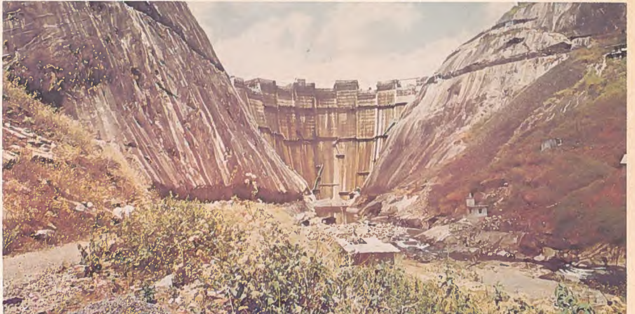
Les ingénieurs-conseils canadiens excellent dans le domaine de l'énergie. Ci-dessus, la construction du barrage Idikki d'une hauteur de 555 pi (169 m) dans le sud de l'Inde. Ce barrage est le plus important d'une série de trois d'un complexe hydro-électrique qui produira à pleine capacité 780 000 kilowatts; c'est un arche fin en béton, parabolique, à double courbure, d'une épaisseur de 25 pi (7.6 m) au sommet et de 75 pi (22.8 m) à la base. Il a une longueur de 1 250 pi (381 m).
