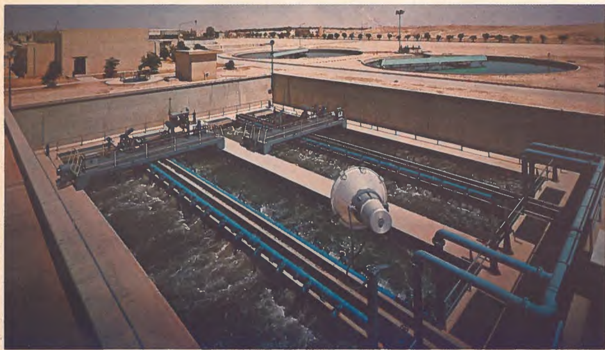
Pour répondre au défi de la protection de l'environnement, les ingénieurs-conseils canadiens ont acquis une expertise éminente, allant de la détection au contrôle de l'environnement, qu'il soit terrestre, aérien ou maritime. Ci-dessus, l'un des nombreux projets auxquels ont collaboré les ingénieurs-conseils canadiens dans ce domaine: l'usine de traitement des eaux usées à Riyad en Arabie Saoudite.
