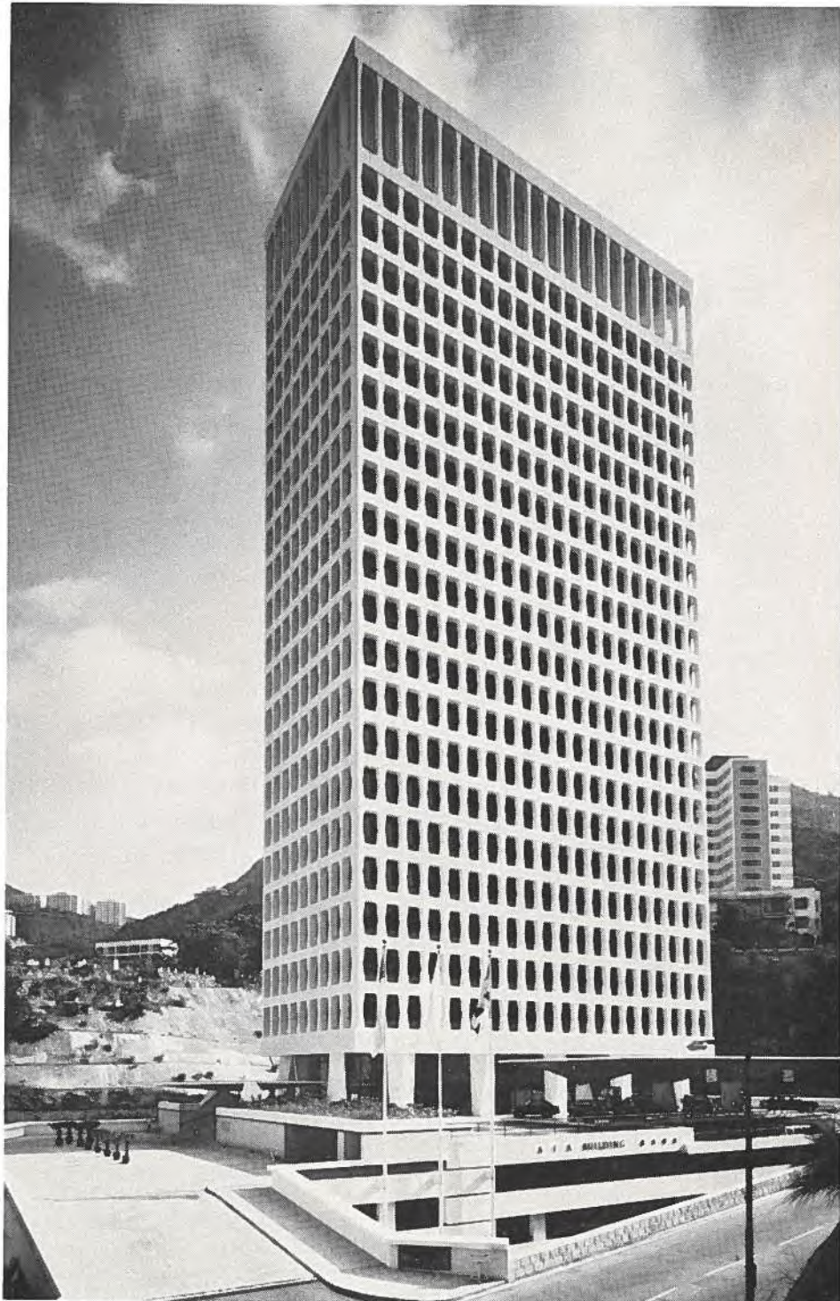
Le premier édifice sans colonnes de Hong Kong, construit en béton précontraint, compte 28 étages et abrite le siège social de l'American International Assurance Company, une des plus importantes sociétés du pays.
