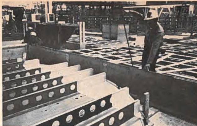
Voici les éléments du fuselage de l'avion géant L-1011 TriStar Jetliner fabriqué par la société Lockheed. Le fournisseur est la société Northwest Industries of Edmonton qui a livré les éléments dans le délai imparti. Northwest est une division de CAE Industries Ltd. de Montréal.
