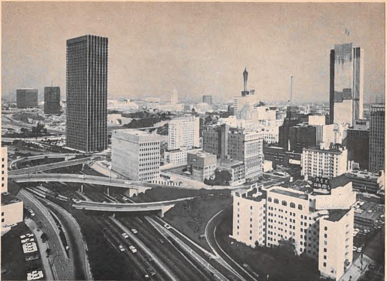
Los Angeles, la plus grande agglomération démographique, industrielle et commerciale aux É.-U., après New-York.
