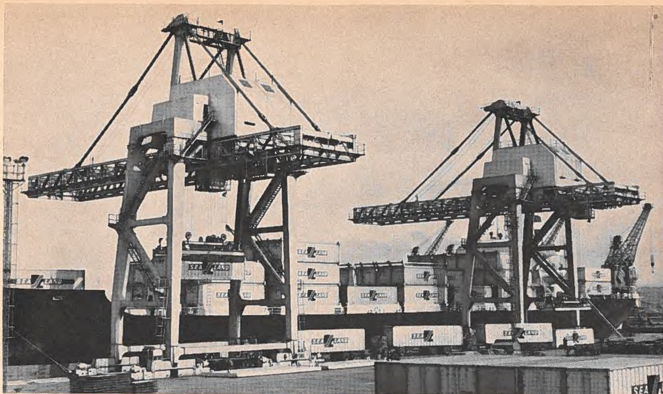
Aux quais de Grangemouth, deux grues transbordeurs, de 32 tonnes chacune, chargent un navire à conteneurs.
