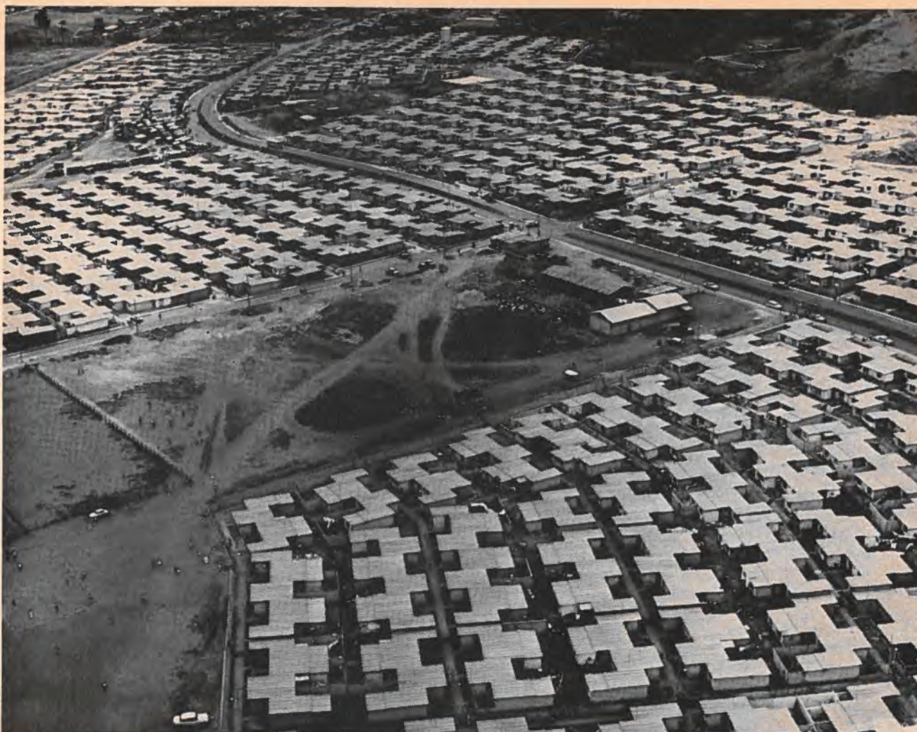
La BID a aidé à diminuer la pénurie critique de logement au Guatemala avec un prêt de 5.3 millions. Il en a résulté la construction de 5,260 unités d'habitation dont un bon groupe figure dans cette photo. Elles sont occupées par des familles dont les revenus s'échelonnent de 40 à 140 dollars par mois.
