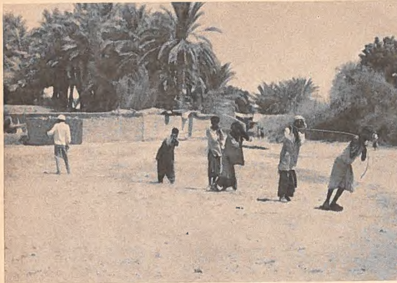
Le câble d'une ligne de transmission reliant Sukkur à l'aménagement de Khairpur, au Pakistan occidental, est tiré à bras et non pas par des camions de 20 tonnes, comme dans les pays de l'Ouest. On emploie parfois des chars à boeufs.
