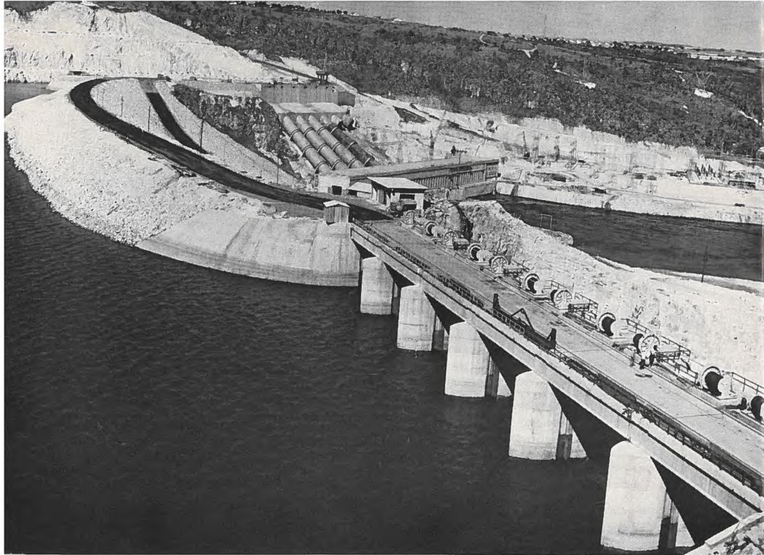
En juillet dernier a eu lieu l'inauguration de la centrale d'Estreito. On en a entrepris la construction après une étude des emplacements hydro-électriques prometteurs exécutée par un consortium canadien; elle fournit déjà 600 mégawatts et augmentera progressivement sa production.
