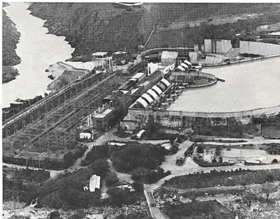
Ci-dessus la centrale Paulo Afonso sur le São Francisco photographiée voilà un an. Elle fournit de l'énergie à la zone industrielle en plein essor du Nord-Est; sa capacité actuelle, 1,215 mégawatts, sera portée à 2,215 mégawatts d'ici 1974.
