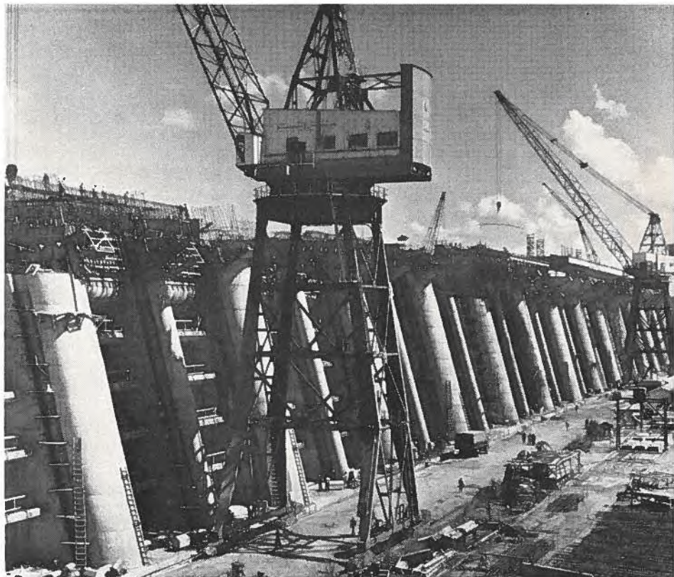
Parmi les grands projets hydro-électriques du Brésil se trouve Jupia, qui fait partie du grand complexe d'Urubupunga. Ci-dessus la centrale en voie de construction; elle produit déjà, mais n'atteindra pas sa capacité totale de 1,400 mégawatts avant 1973.
