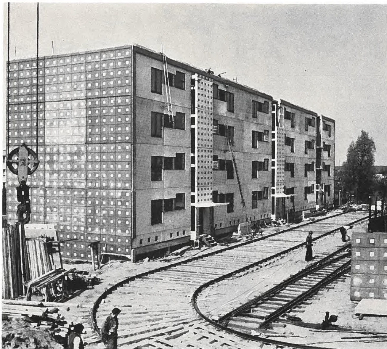
A Hambourg, il ne faut que quatre travailleurs et une grue pour construire des maisons appartements de 48 unités. Les locataires peuvent emménager trois mois après le début des travaux. Comme les habitations sont construites à un rythme rapide, on a constamment besoin d'articles de quincaillerie.
