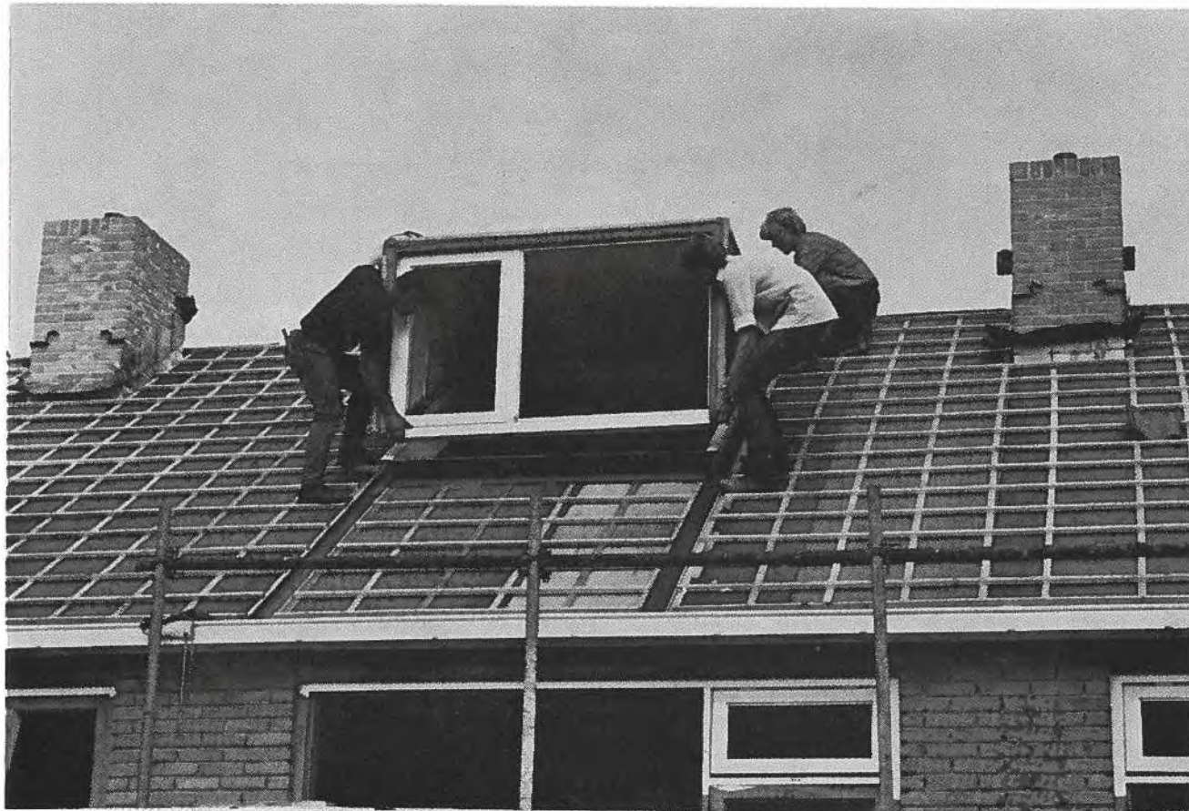
Cette photographie illustre comment les Hollandais préparent une couverture pour la pose des tuiles. A noter le treillage sur lequel les tuiles seront posées. Les ouvriers installent ici un genre de lucarne qu'on voit beaucoup dans les habitations unifamiliales de Hollande et qui est souvent préfabriquée.
