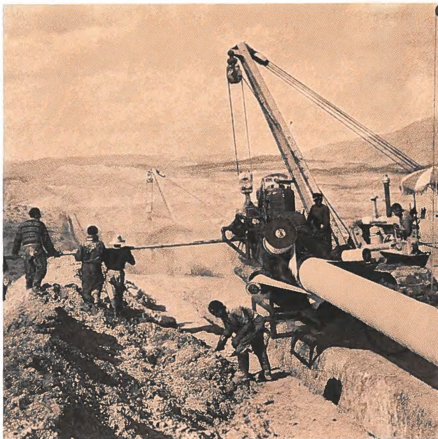
La pose d'un oléoduc en Algérie est souvent difficile. Le pays possède maintenant quatre pipe-lines dont l'un vient d'être parachevé. Ils transportent le pétrole brut aux raffineries du pays ou aux ports d'où on l'exporte.
