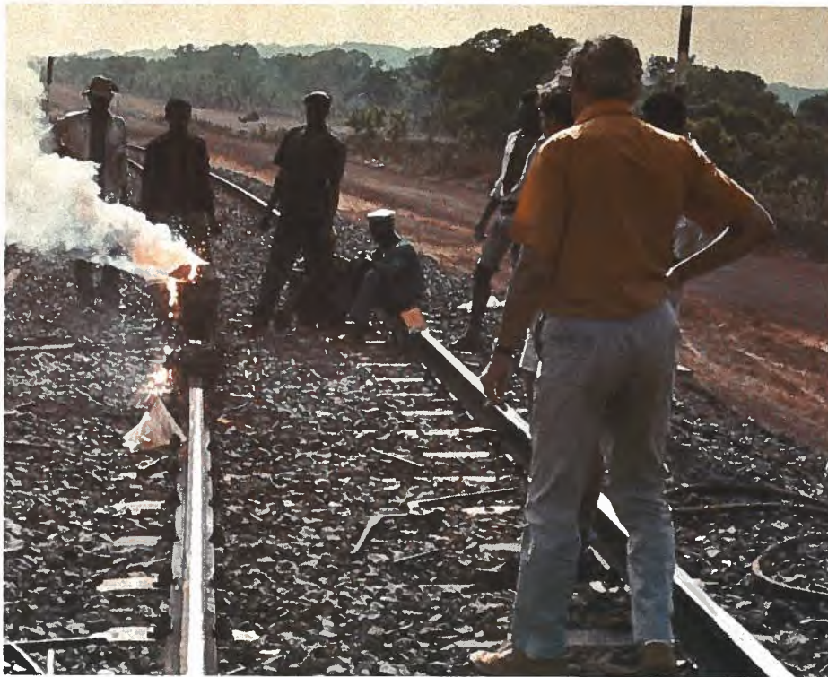
Thermite welding on Chemin de fer de Boké.
