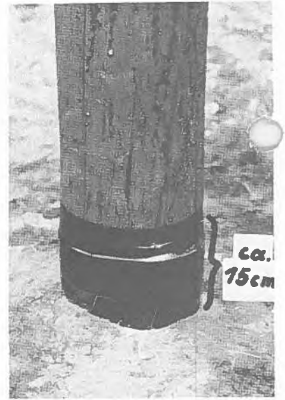
(1) Preservative Wrapper for Wood Poles (1) Enveloppe protectrice pour les poteaux en bois
