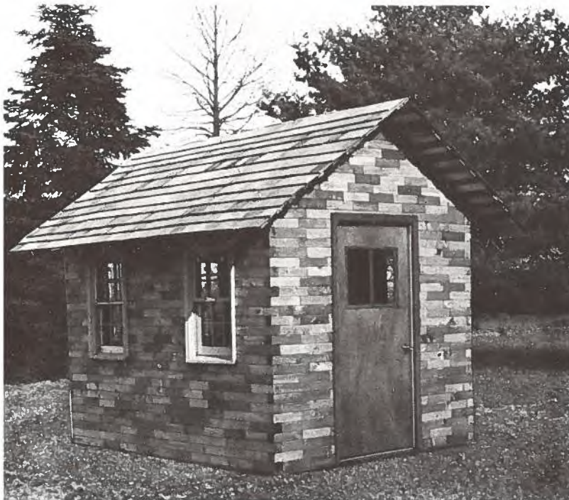
Solid Wood Construction Blocks (See page 2) Construction en blocs de bois massif (Voir page 2)
