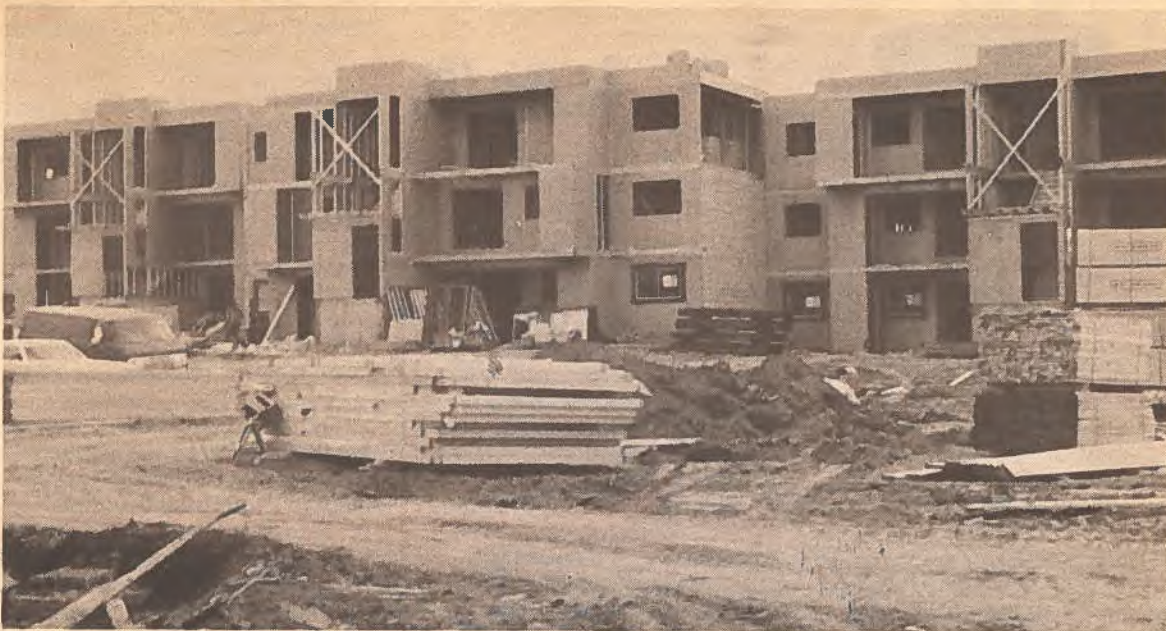
Construction métrique à Calgary en Alberta.
