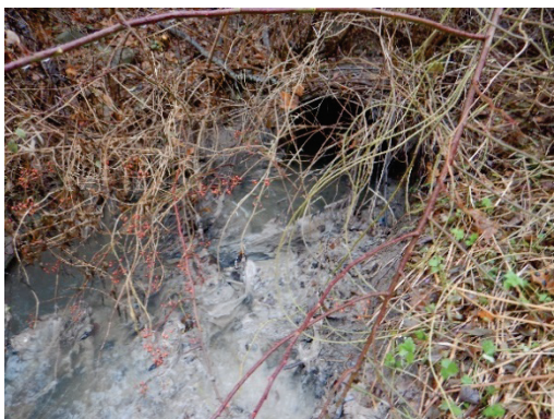
Image 1 : Des eaux usées non traitées ont débordé dans le fossé en raison de l'obstruction d'une canalisation.
