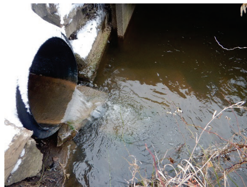
Image 1 : Des eaux usées non traitées ont débordé dans le fossé en raison de l'obstruction d'une canalisation.
