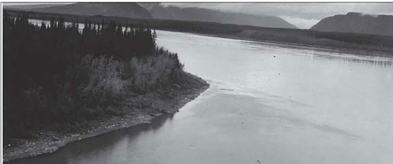
CAMSELL BEND DEPUIS LE KILOMÈTRE 463,5 — VUE VERS L'AMONT (1987)
