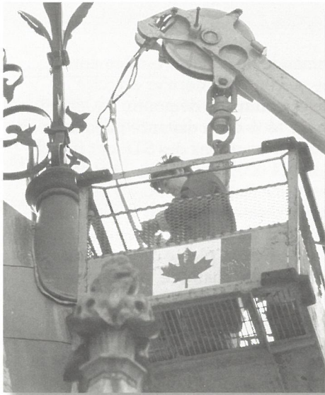
Un échantillon de la girouette de la bibliothèque du Parlement, à Ottawa, est prélevé.
