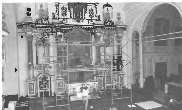
La chapelle des Ursulines en cours de traitement.
