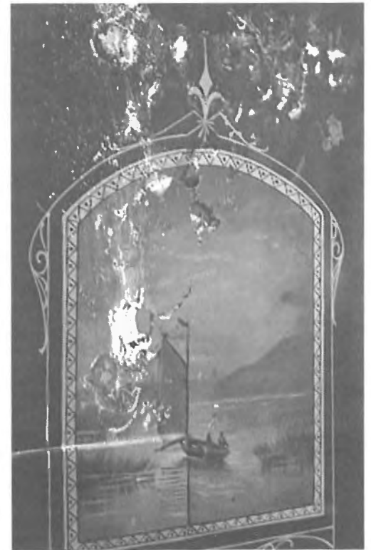
Détail de la peinture à l'intérieur avant traitement. On y voit les trous et les pertes causés par la corrosion.
