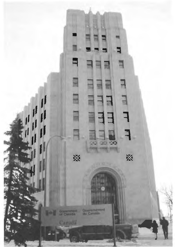
L'édifice Fédéral (appelé aussi Dominion Public Building), à Winnipeg, a été construit en 1937 dans le style gothique moderne et se trouve sur un terrain en angle.
