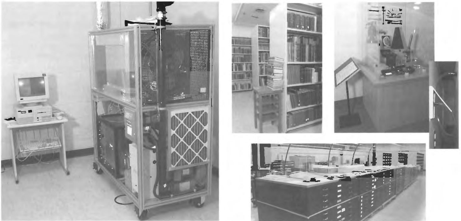
Figure 3. Appareil de régulation de l'HR n° 1, installé dans la section des archives du Musée des sciences et de la technologie du Canada. L'appareil, situé dans une pièce réservée, alimente en air une vitrine d'exposition du hall, des armoires de rangement et une salle des livres rares.
