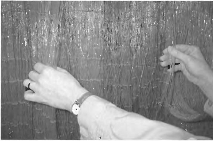
Détail des points noués en monofilament de nylon composant la structure du rideau.
