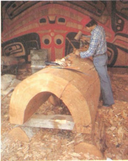
L'équipe des six apprentis de Davidson termina au cours de l'été 1978 l'importante façade de l'édifice. Tous se mirent aussitôt au travail sur les quatre grandes colonnes intérieures.
