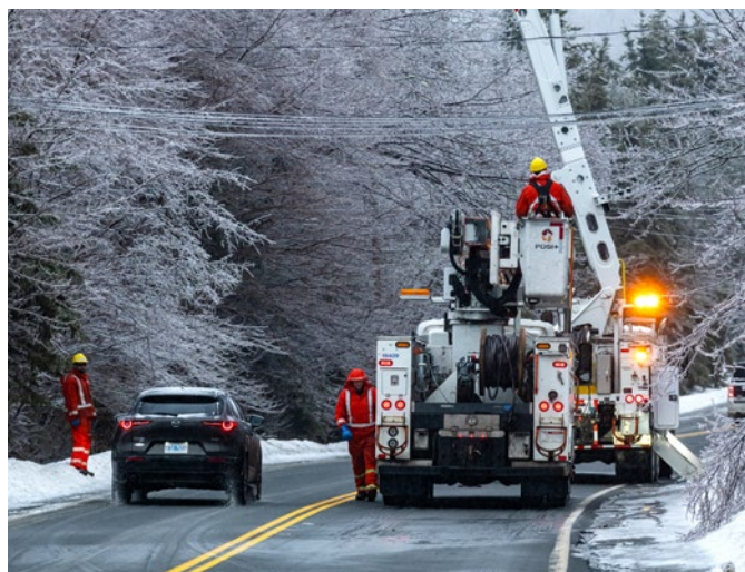
Une équipe d'un service public d'électricité travaille à rétablir le courant après une importante tempête de verglas à Beaver Bank, en Nouvelle-Écosse, le 2 février 2022.
