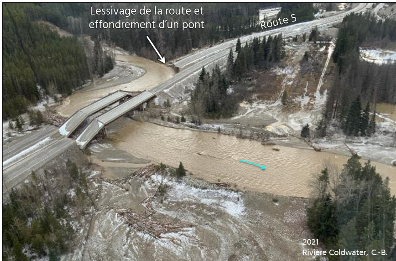
Figure 3.2. Effondrement d'un pont sur la route 5 dû à l'érosion et à l'affouillement de la rivière Coldwater en novembre 2021. Photo : BGC Engineering Inc.
