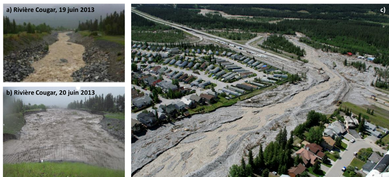
Figure 3.4. Ruisseau Cougar les (a) 19 et (b) 20 juin 2013, photos prises à environ un jour d'intervalle au même endroit sur le cône moyen à supérieur, en direction aval (sud). La largeur moyenne du chenal sur la photo du haut (a) est d'environ 6 m; sur l'image du bas (b), elle s'est élargie d'environ 30 m à 60 m. c) Le chenal du ruisseau Cougar après l'inondation de débris en aval de l'emplacement de (a/b) avec la route 1 bloquée (la « transcanadienne ») traversant le cône inférieur. Dans cette section, le chenal actif s'est élargi jusqu'à 90 m. Photo : Ville de Canmore.
