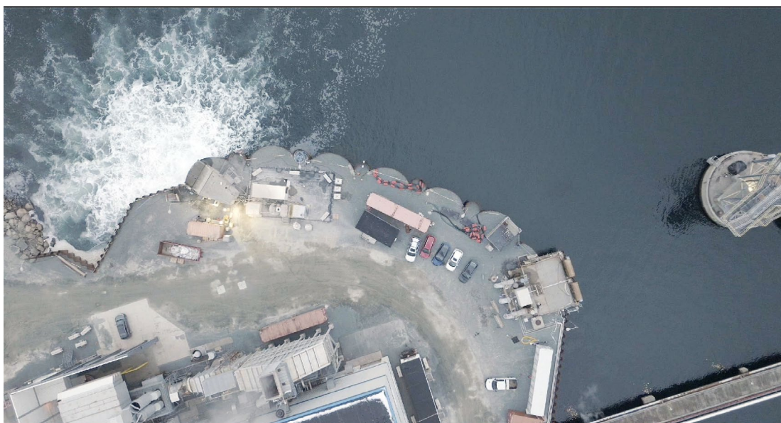
Vue aérienne d'une installation terrestre d'amélioration de l'alcalinité des océans dans le port d'Halifax. Photo fournie par Planetary Technologies.
