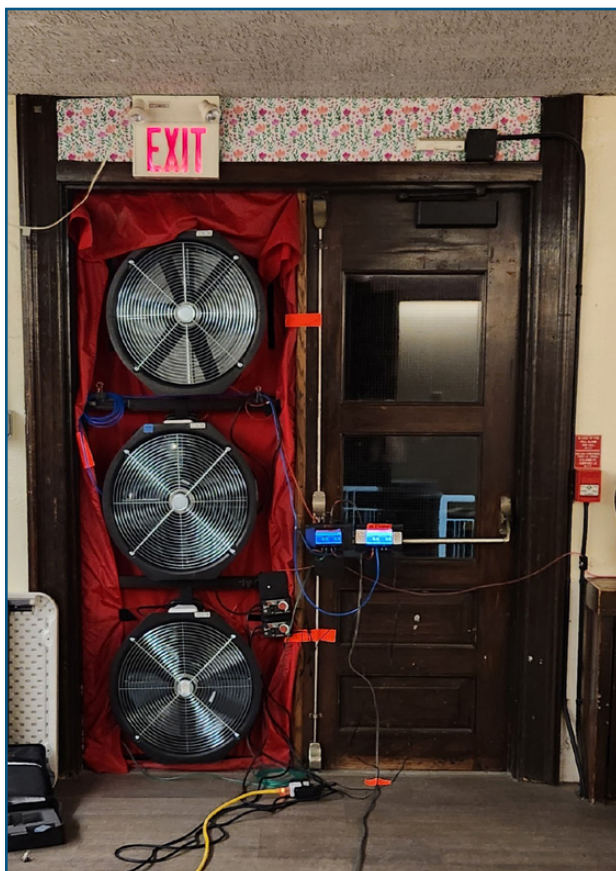
Figure 21 : Alimentation électrique des ventilateurs de l'infiltromètre
