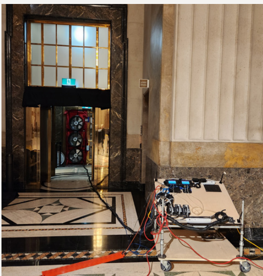
Figure 17 : Réseau câblé pour les essais d'étanchéité à l'air
