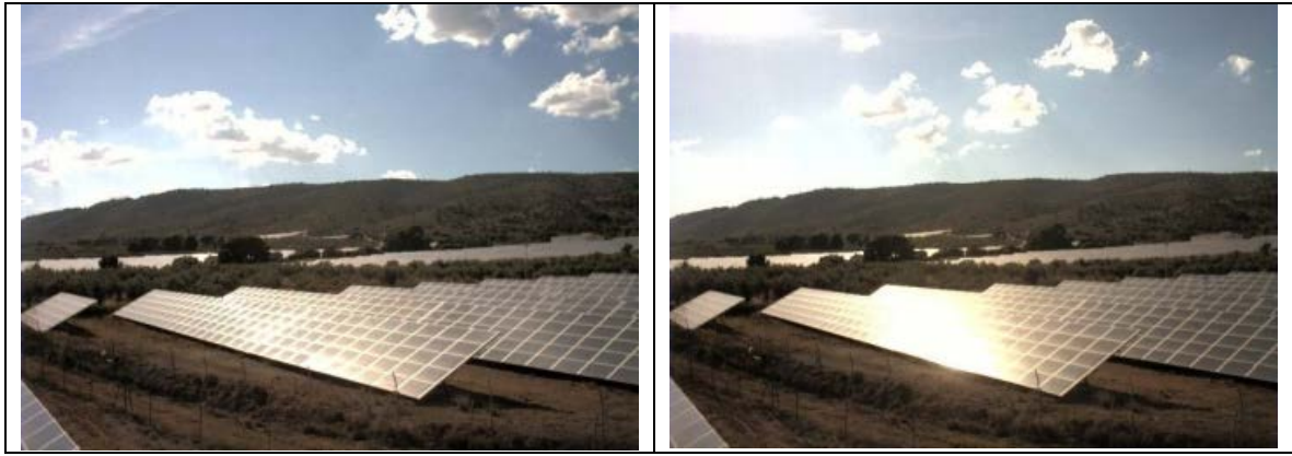
Figure 5. Réflexion par les panneaux solaires
