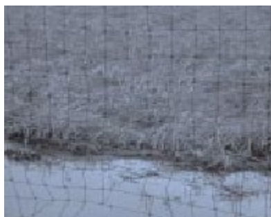
Figure 46: Les clôtures trouées peuvent laisser entrer des mammifères sur les terrains d'aviation
