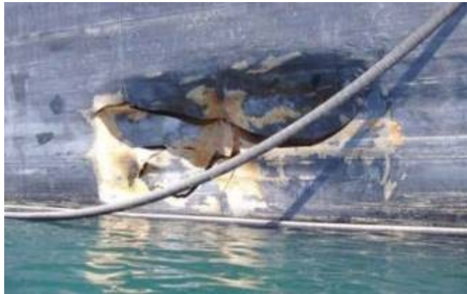
Navire-citerne montrant des dommages causés par la glace
